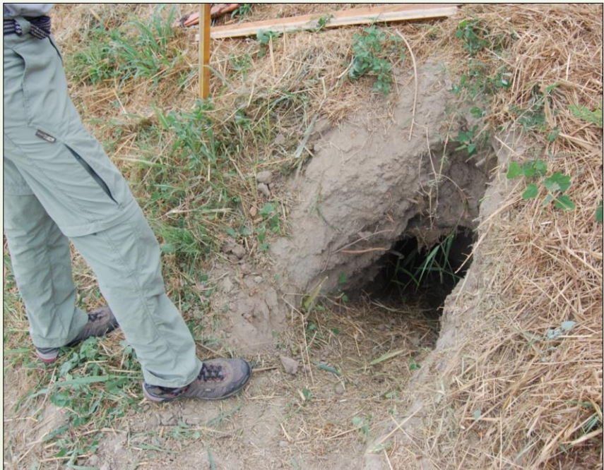
Fig. 2 Una delle aperture di un articolato sistema di tane situato in un rilavato arginale a Finale Emilia (MO)
